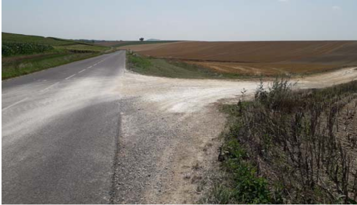
Vue sur le débouché sur la RD 243
